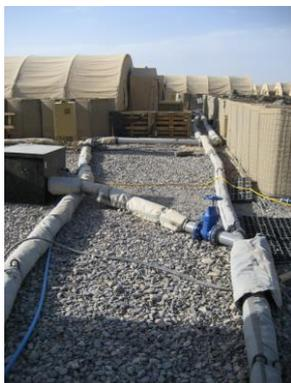
La instalación de las tuberías de vacío es muy flexible. Se adaptan al campamento y se pueden instalar dos o tres ramales desde la estación de vacío para un mantenimiento más sencillo.
